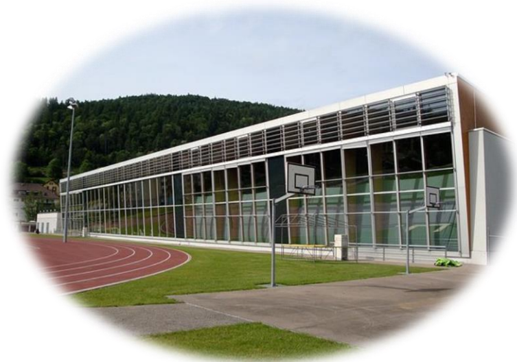
Centre Sportif du Val-de-Travers - Couvet
